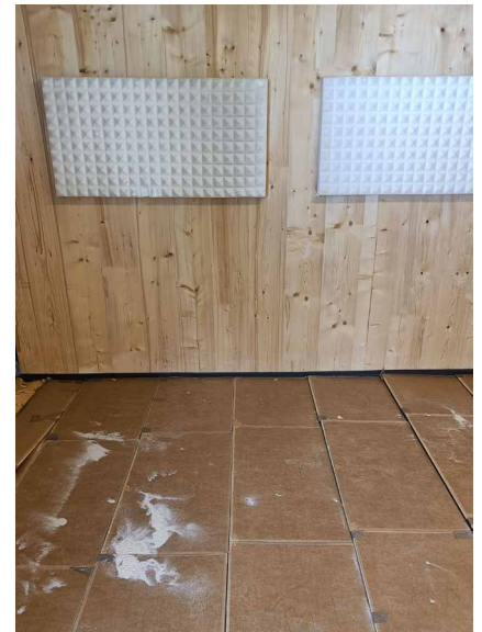
Einbau des Trockenbausystems ohne PIANO
